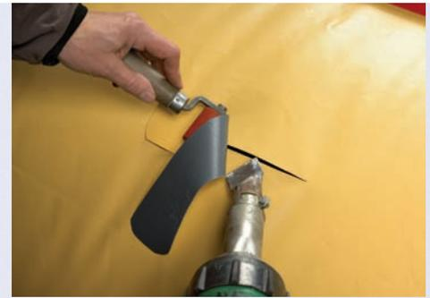
*Reparación con soldadura mediante aire caliente.*
